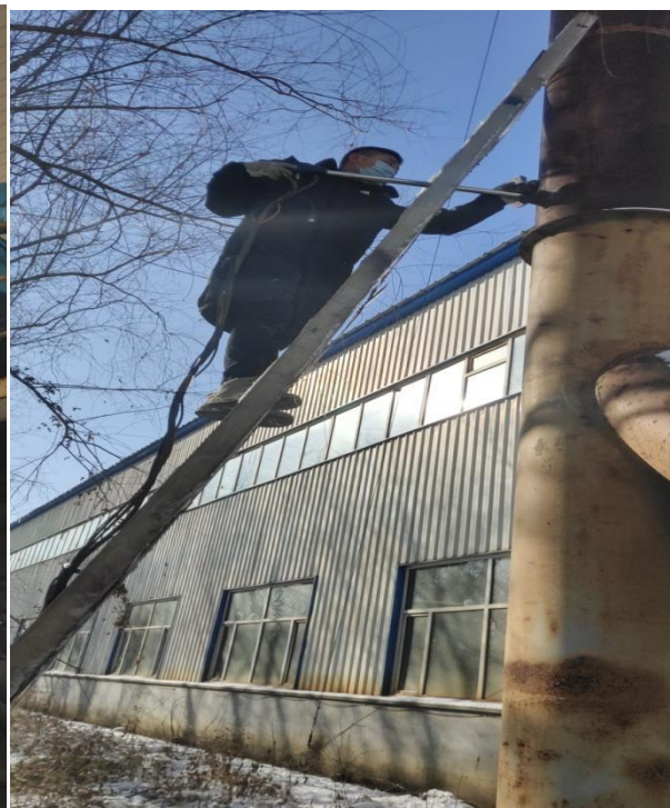
抛丸车间排气筒出口
